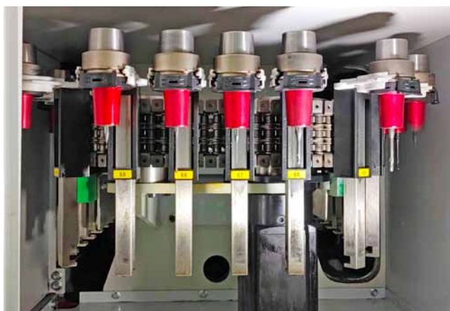
Die Fräswerkzeuge werden zusammen mit ihrem MHT-Düsenkörper im Werkzeugspeicher vorgehalten (Foto: Klaus Vollrath)
